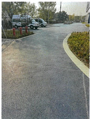
2021. 11. 24 透水铺装(道路及配套设设施区)
