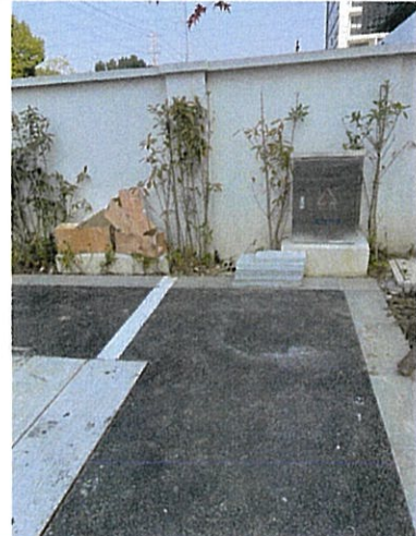
2021. 11. 24 雨水回用设施（道路及配套设设施区）
