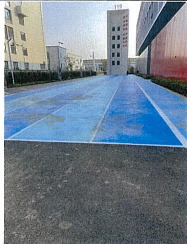
2021. 11. 24 透水铺装（道路及配套设设施）
