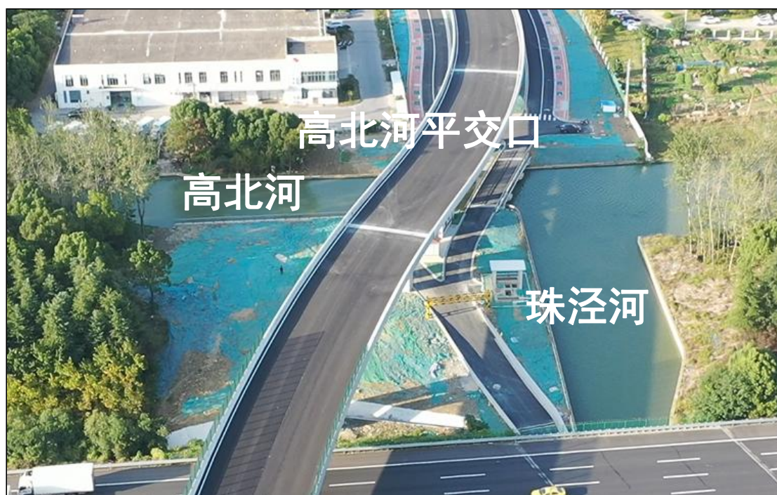
图 1-6 项目区高北河、珠泾河、高北路平交口影像图（2022 年 10 月）
