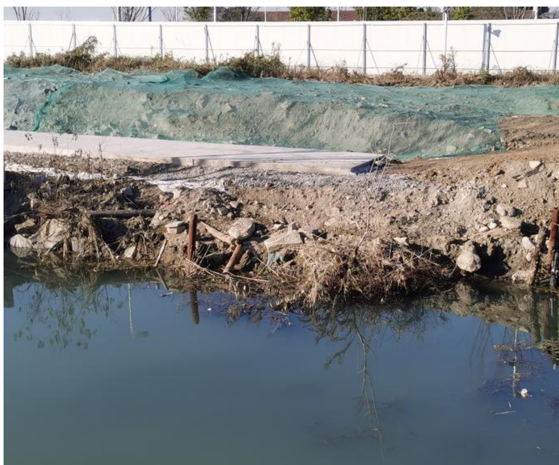
图3-2a 临时措施图（2023年2月，临时苫盖）
