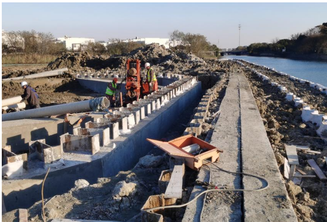
图3-2c 临时措施图（2023年2月，临时排水沟）
