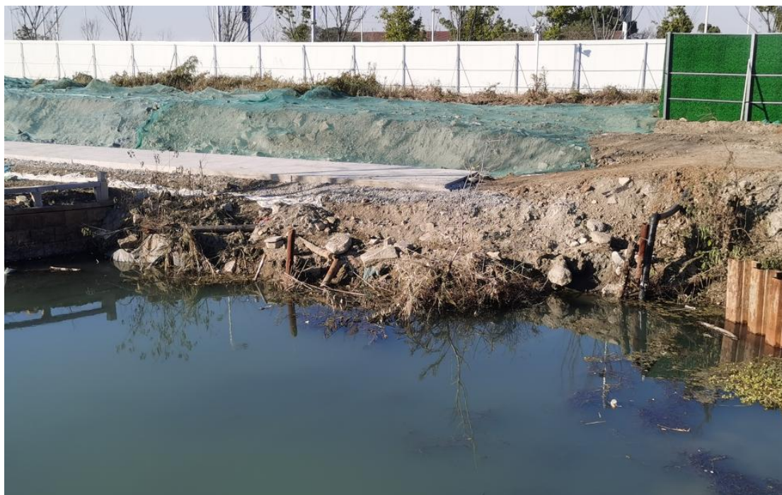
图2-9e 临时措施图（2023年1月，密目网苫盖）
