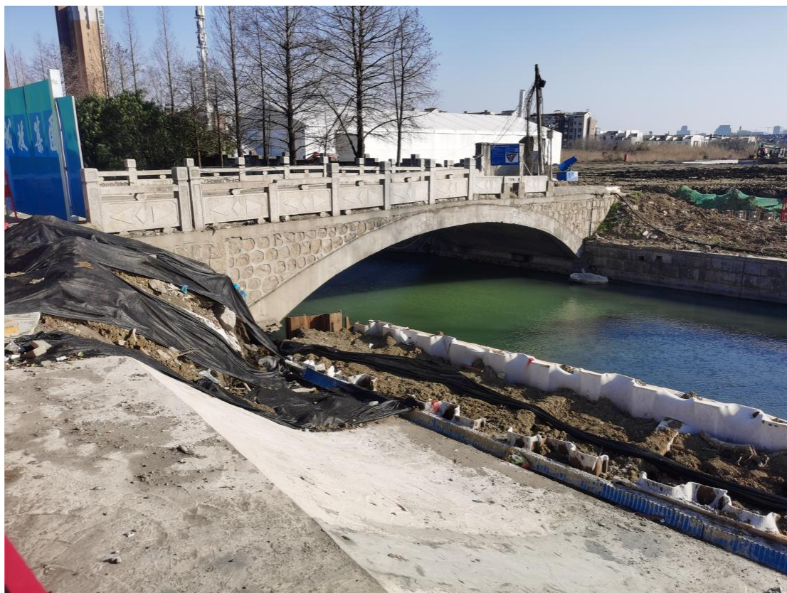
图 2-9b 大寨河路桥现场图（2023 年 1 月，老桥段）
