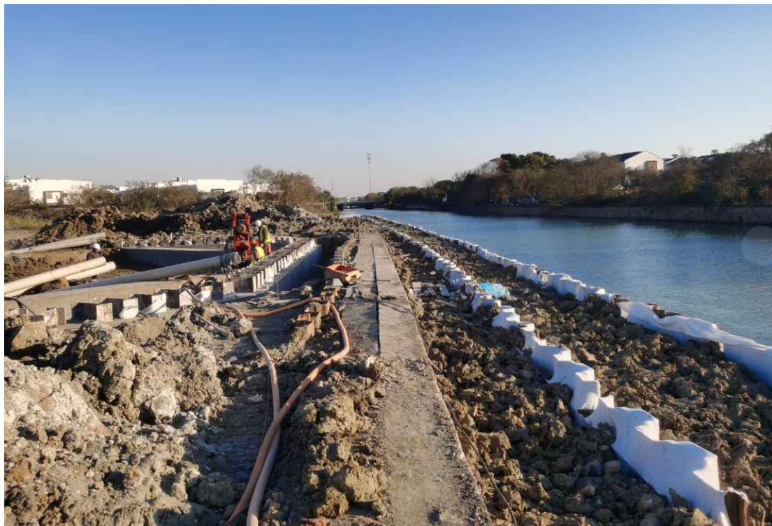
图2-9d 西塘河路桥现场图（2023年1月，围堰段）
