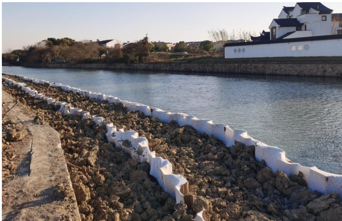
图3-2b 临时措施图（2023年2月，土工布）
