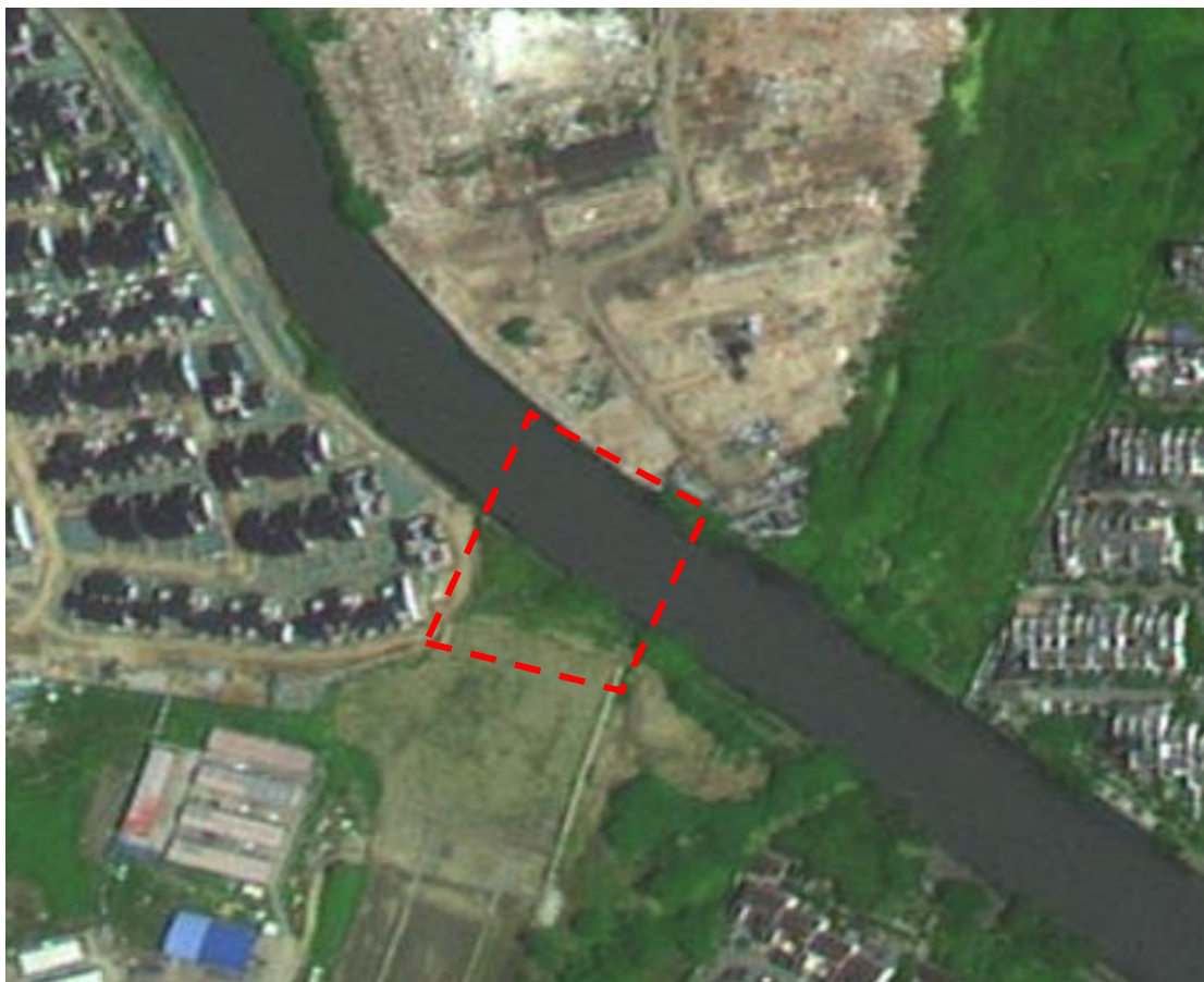
图2-9c 西塘河路桥影像图（2022年2月）
