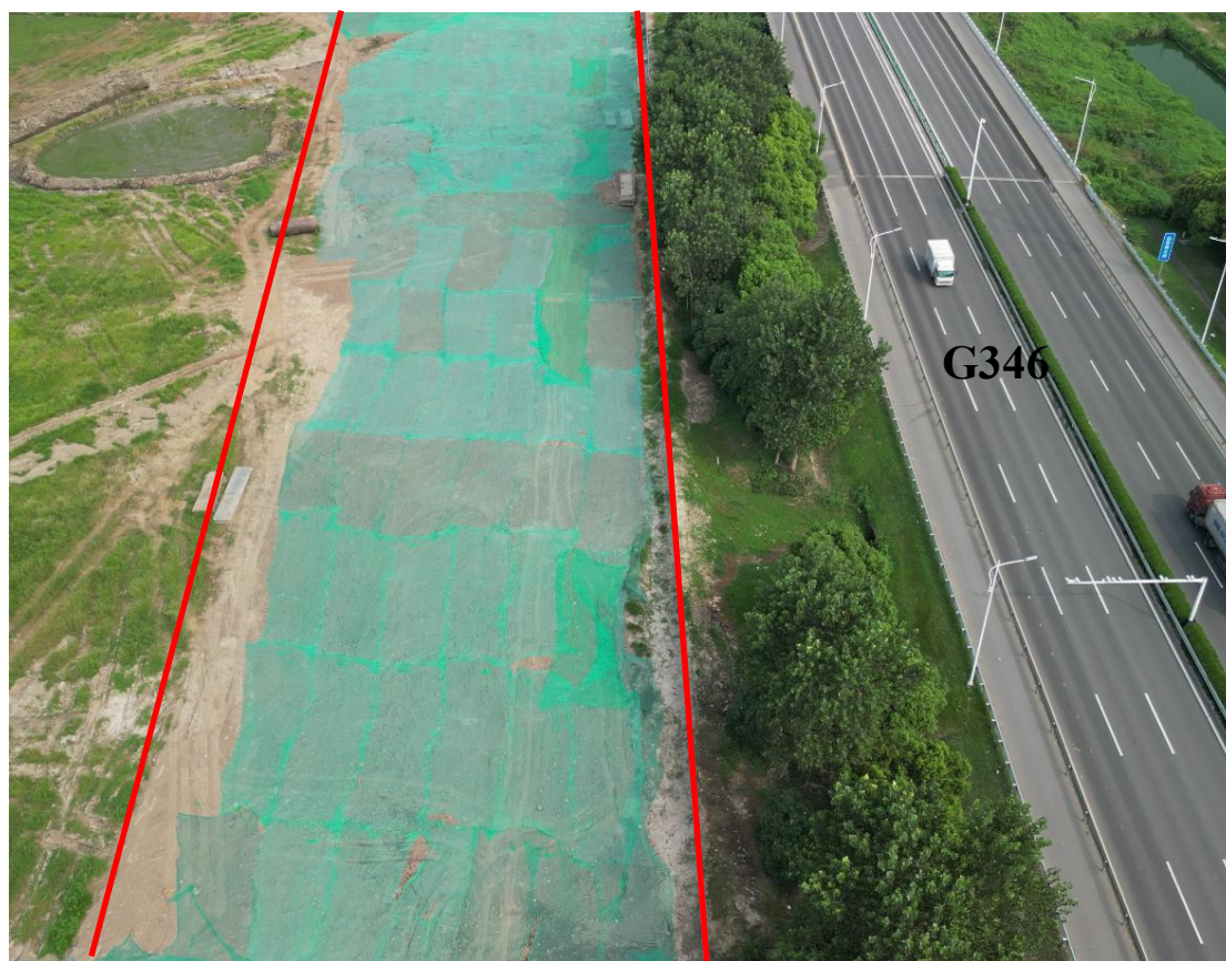
图 2.1-2 工程现场图(已完成管道工程,2023 年 8 月)
