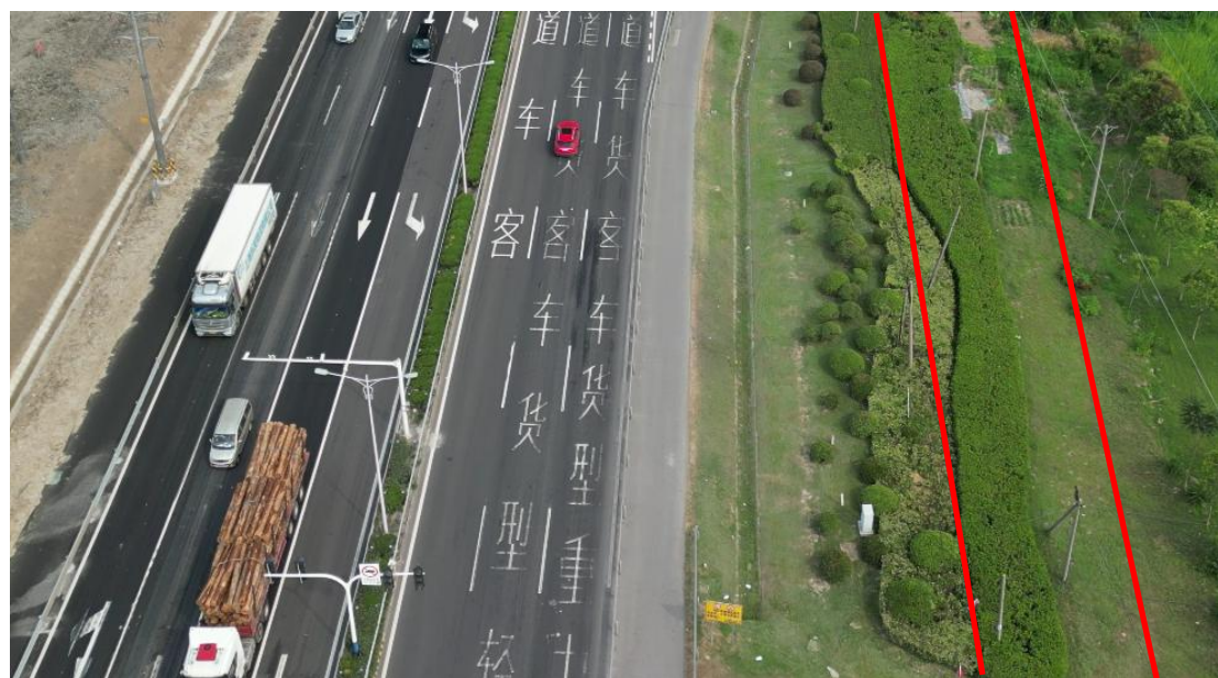
图 2.1-4 工程现场图（管道工程未开始，2023 年 8 月）
