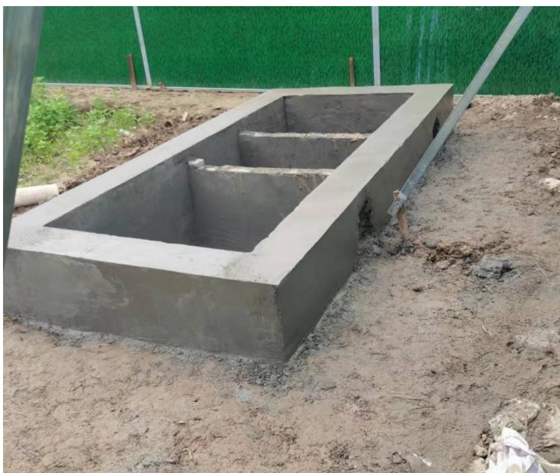
图3.5-2 临时措施图（2023年8月，沉沙池）
