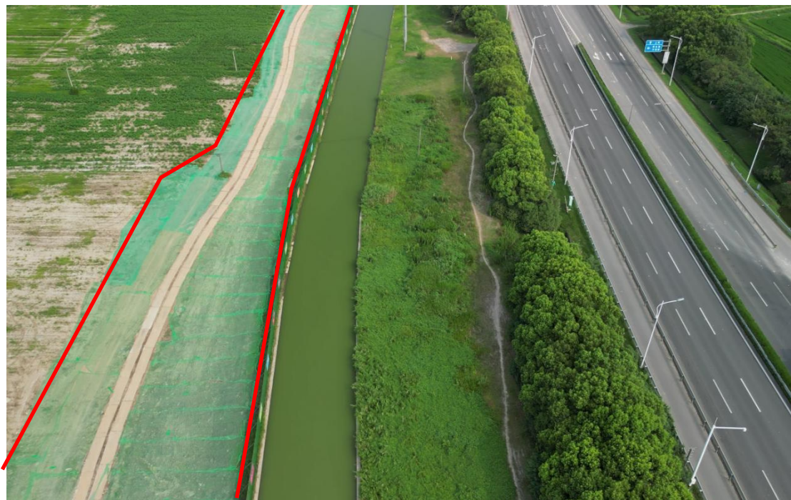
图 2.1-3 工程现场图（已完成管道工程，2023 年 8 月）
