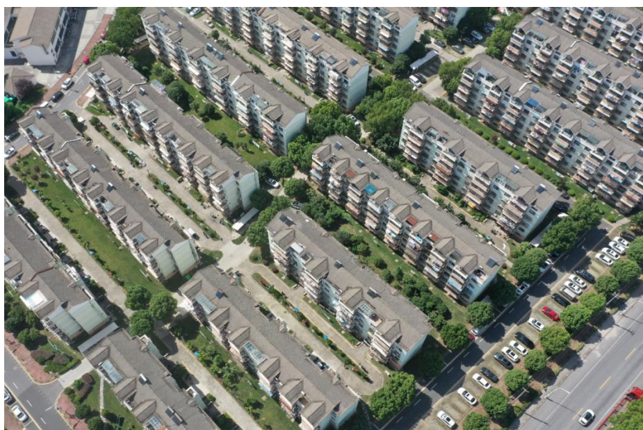
图 2.1-5 工程现场图（老旧小区现状图，2023 年 8 月）
