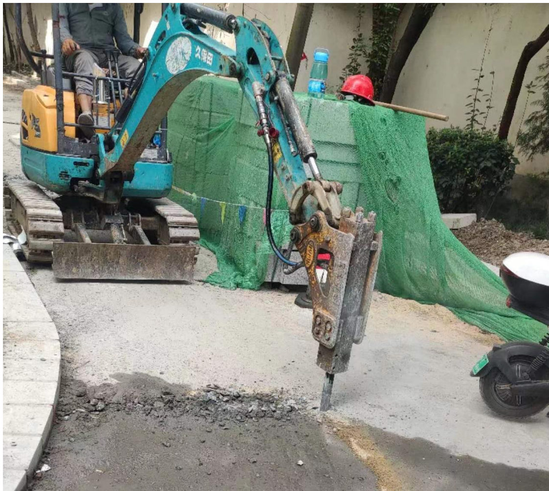
图 2.1-6 工程现场图（管道工程施工现状，2023 年 8 月）
