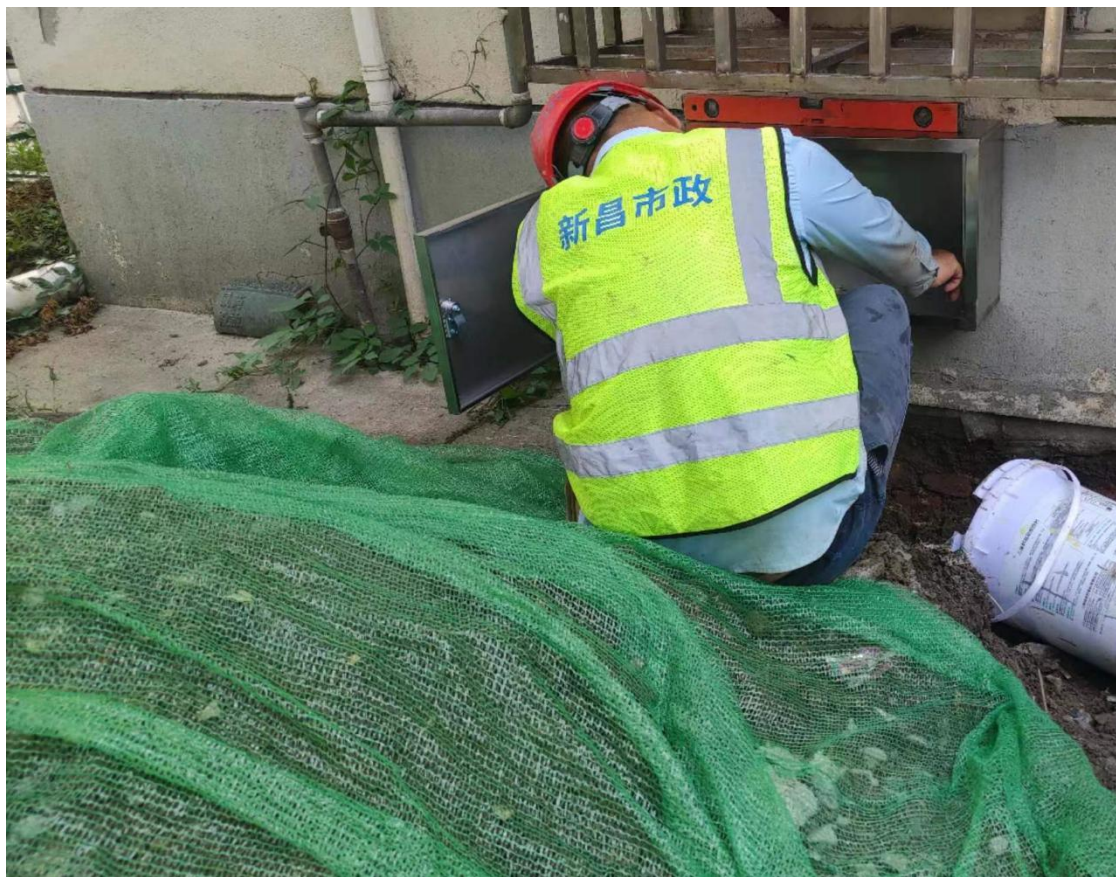
图3.5-1 临时措施图（2023年8月，临时苫盖）
