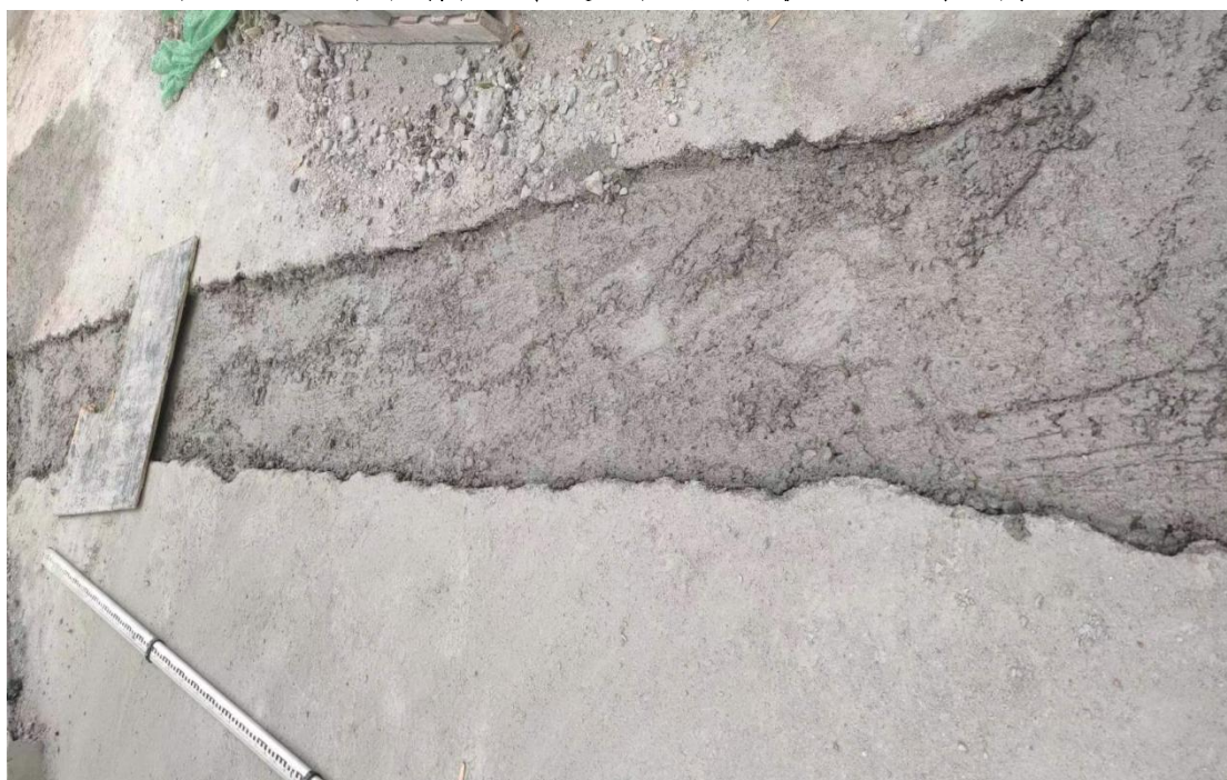
图 2.1-7 工程现场图（已敷设完给水管恢复现状，2023 年 8 月）
