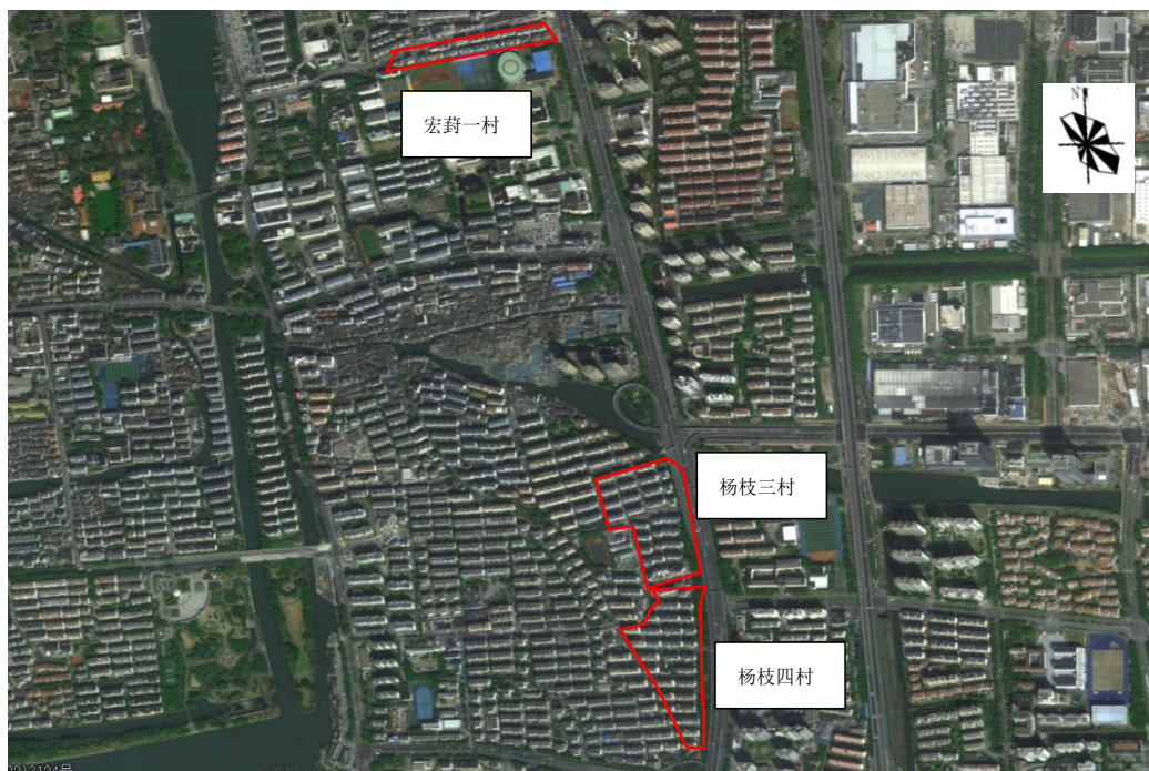
图 2.1-4 工程影像图（2022 年 9 月）
