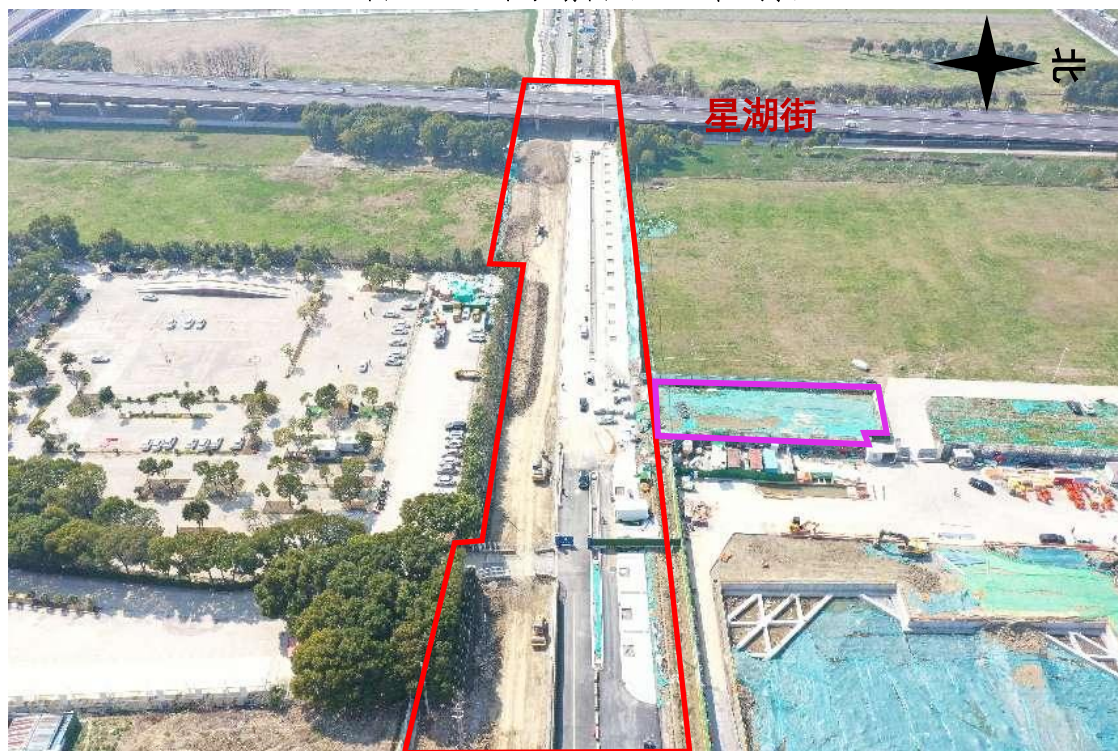
图 2.1-7 工程现场图 (2025 年 3 月)
