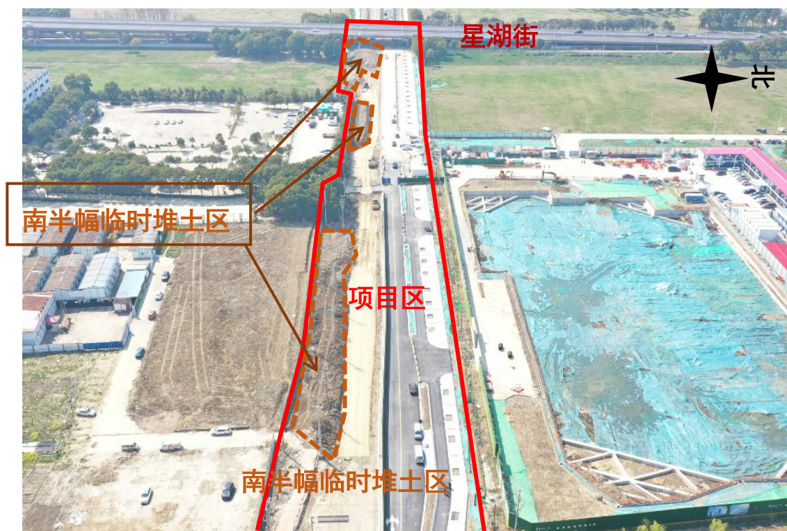
图 2.2-3 南半幅临时堆土区 (2025 年 3 月)
