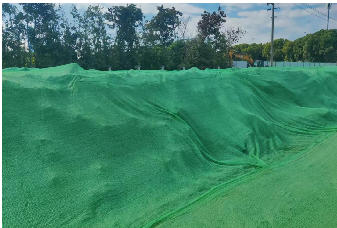
图 3.5-2 密目网苫盖（2024 年 5 月）-已拆除
