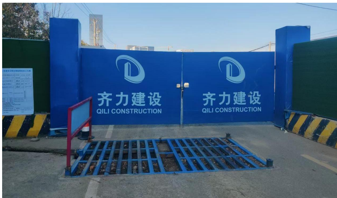
图 3.5-1 洗车平台（2024 年 5 月）-已拆除
