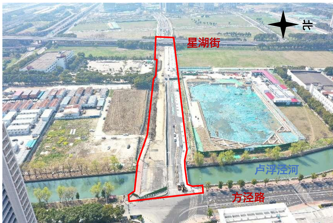
图 2.1-6 工程现场图 (2025 年 3 月)
