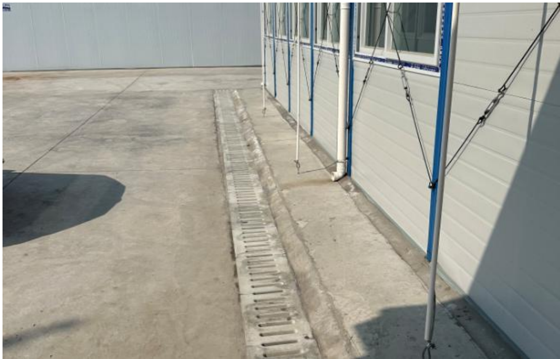
图 3.5-4 临时排水沟（2025 年 3 月）
