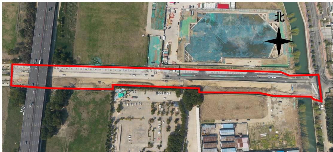
图 2.1-5 工程现场图（2025 年 3 月）
